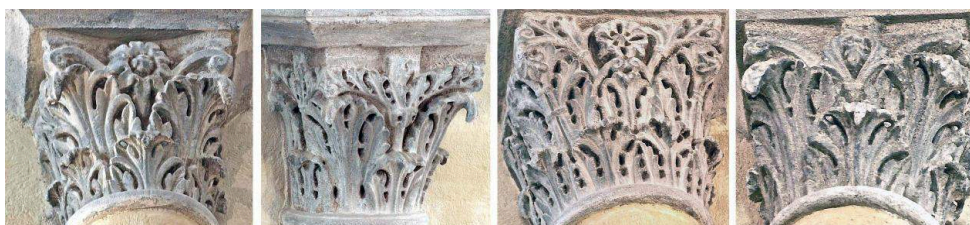
Chapiteaux des deux piles orientales de la croisée (chapiteaux 59, 60, 61, 62)
