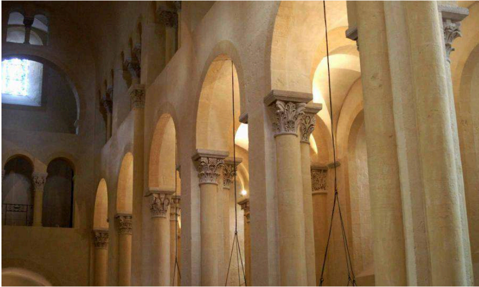
Vue de la nef vers l'ouest
