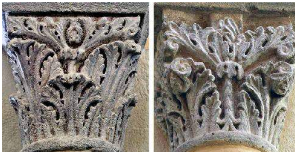
Chapiteau végétal de type 1' (caulicole partiellement dégagé) et de type 1'' (caulicole entièrement dégagé)
